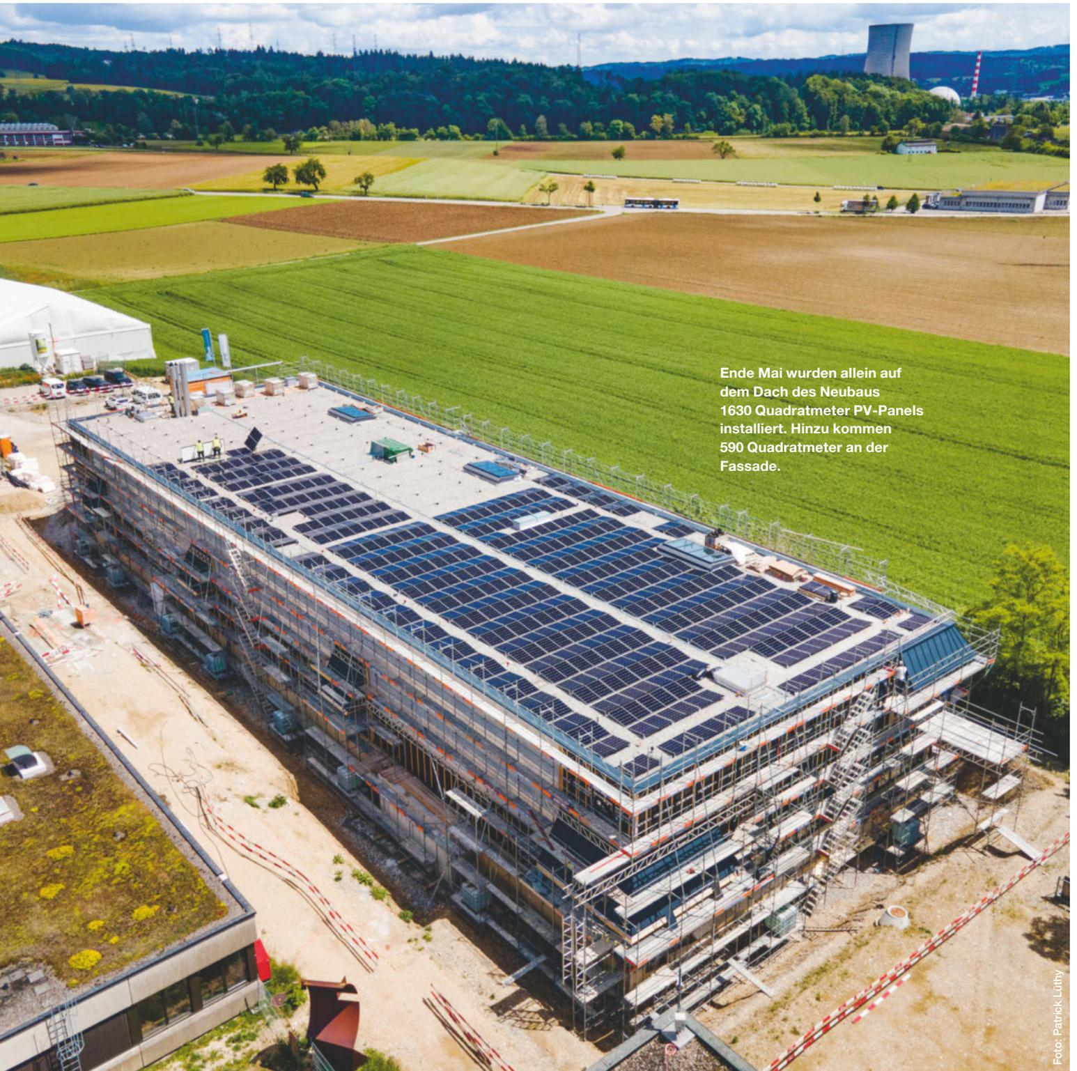
Ende Mai wurden allein auf dem Dach des Neubaus 1630 Quadratmeter PV-Panels installiert. Hinzu kommen 590 Quadratmeter an der Fassade.
